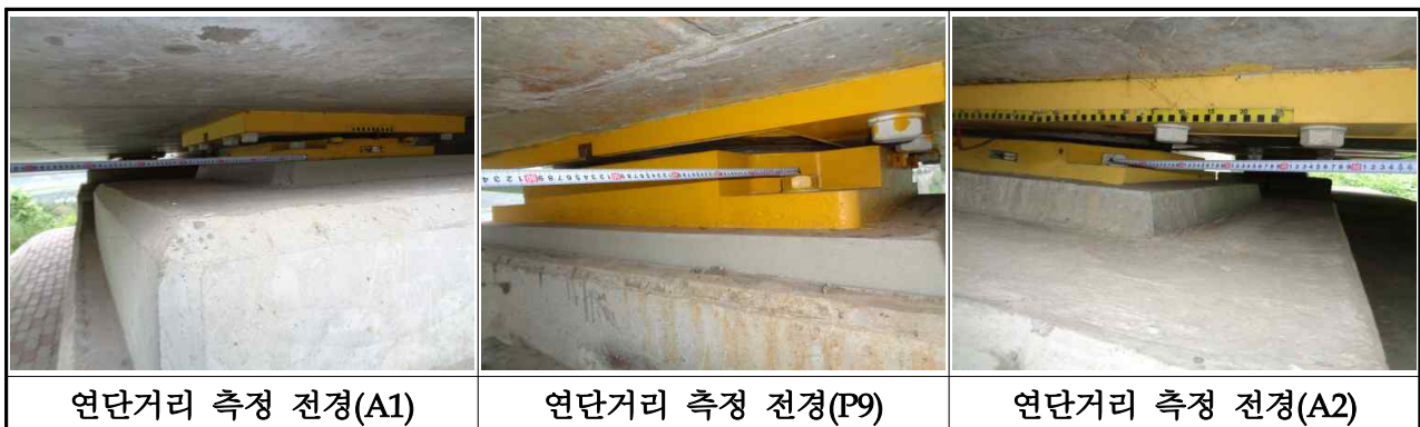
【사진 3.3.14】 연단거리 측정 전경
