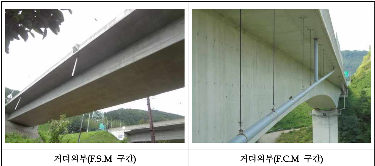
【사진 3.2.1】 거더외부 전경(대구)
