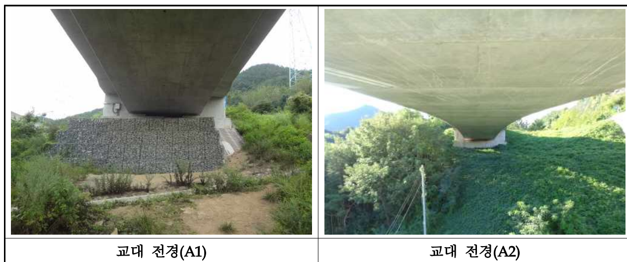
【사진 3.3.7】 교대 전경(부산)
