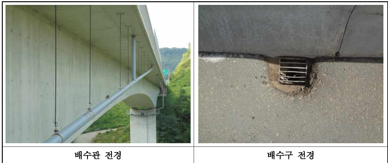
【사진 3.2.20】 배수구 및 배수관 전경(대구)
