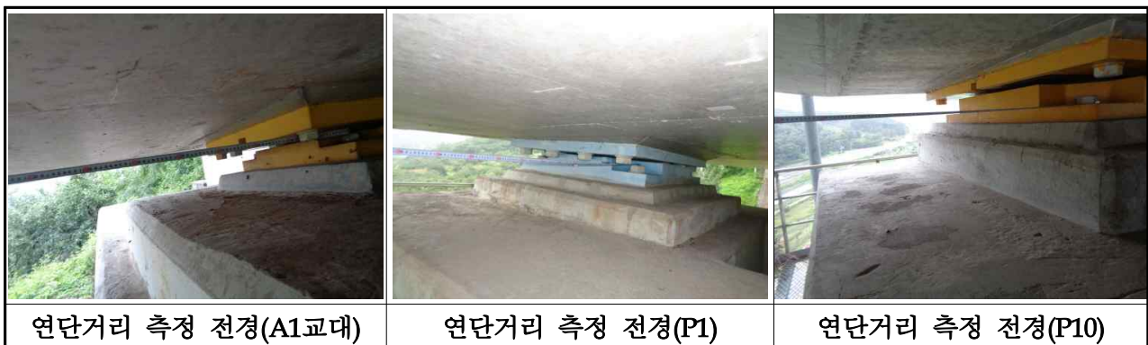
【사진 3.2.15】 연단거리 측정 전경(대구)
