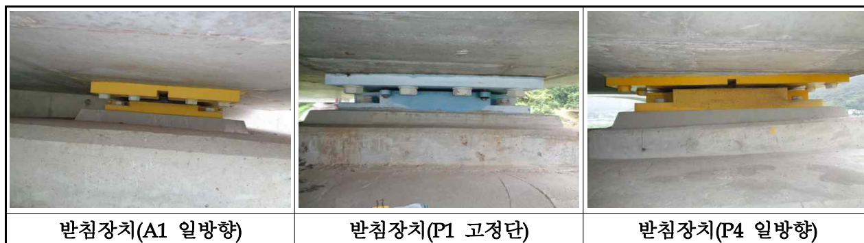
【사진 3.3.12】 교량받침 전경(부산)
