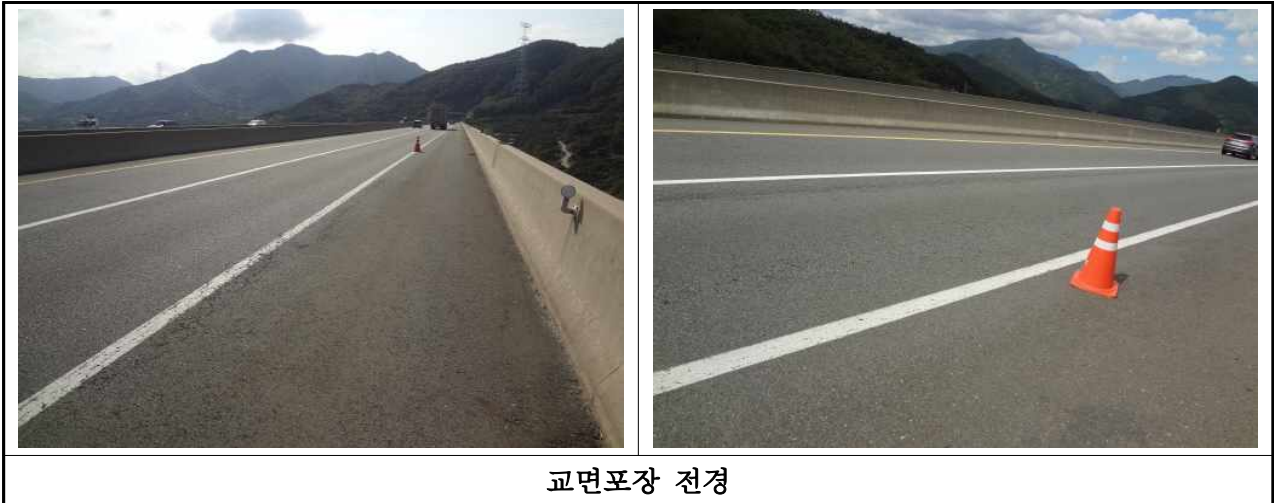
【사진 3.3.17】 교면포장 전경(부산)
