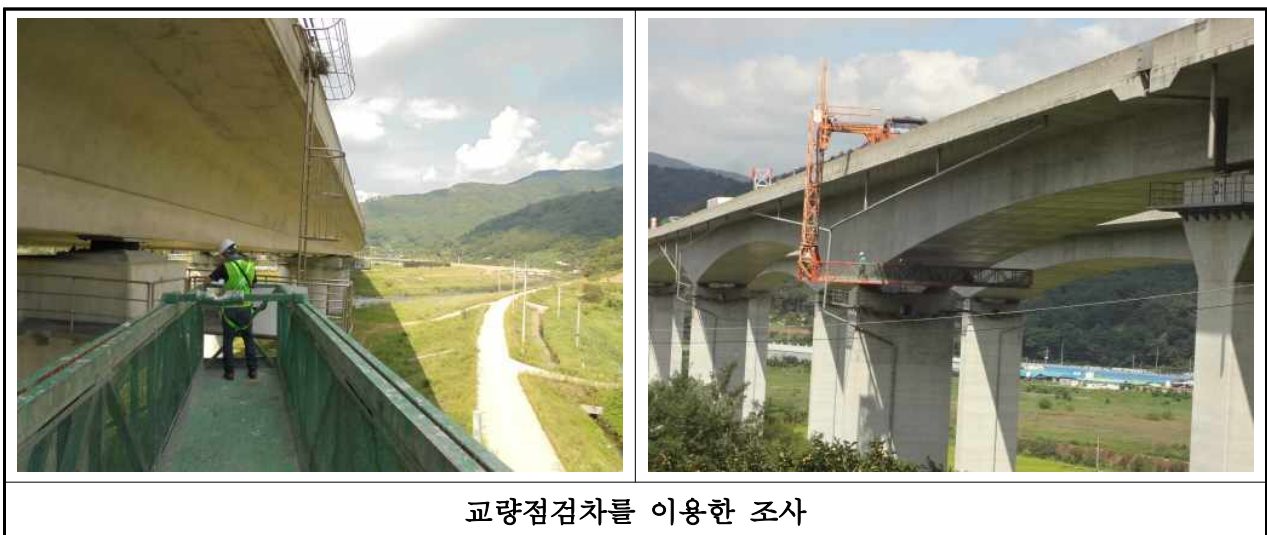
【사진 3.1.1】 교량점검차 이용한 근접 육안조사
