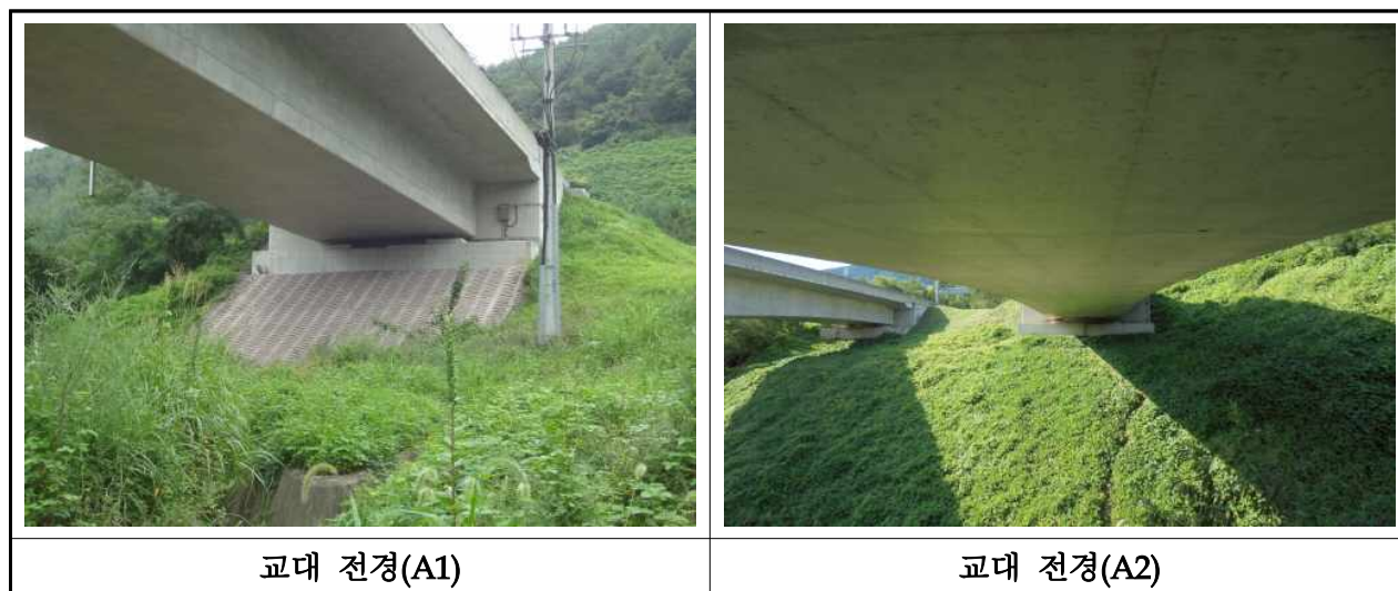
【사진 3.2.8】 교대 전경(대구)
