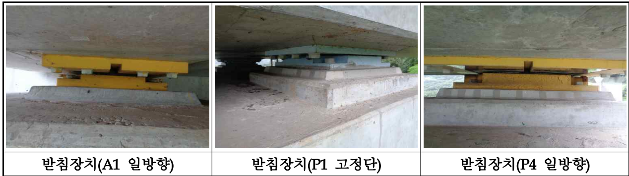
【사진 3.2.13】 교량반침 전경(대구)
