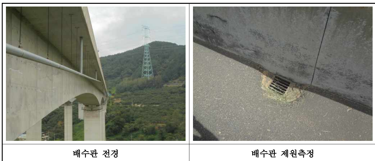
【사진 3.3.19】 배수관 전경
