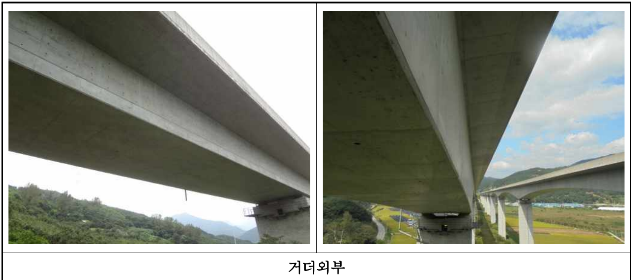
【사진 3.3.1】 거더외부 전경(부산)
